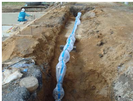
▲ 配水管D I P φ100 布設工事技術研修（平成23年11月9日）
