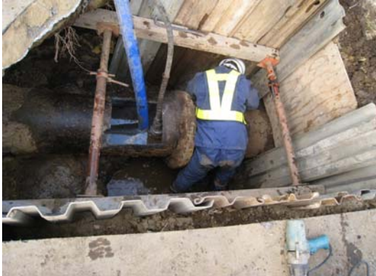
【鋼管の電食漏水による布設替え状況】
