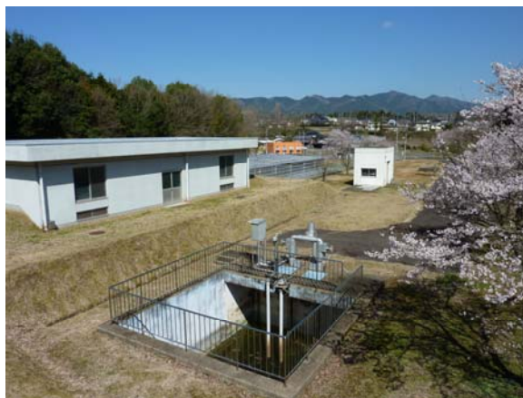
▲ 石岡市水道（八郷中央浄水場）
