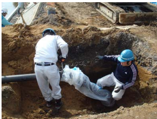
▲ 配水管D I P φ100 布設工事技術研修（平成23年11月9日）
