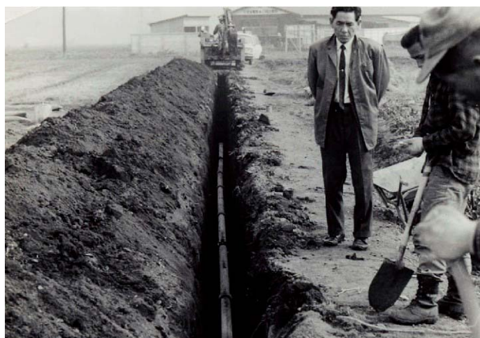
配水管布設工事（昭和46年頃）
