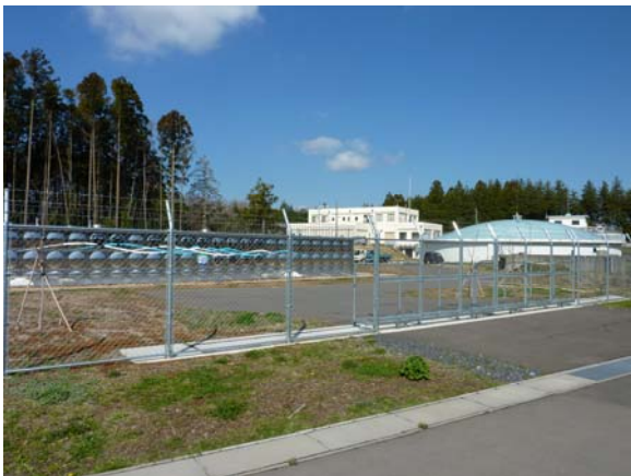
▲ 小美玉市水道（美野里浄水場）
