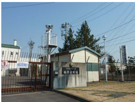
▲ 柏原配水場 監視カメラ
