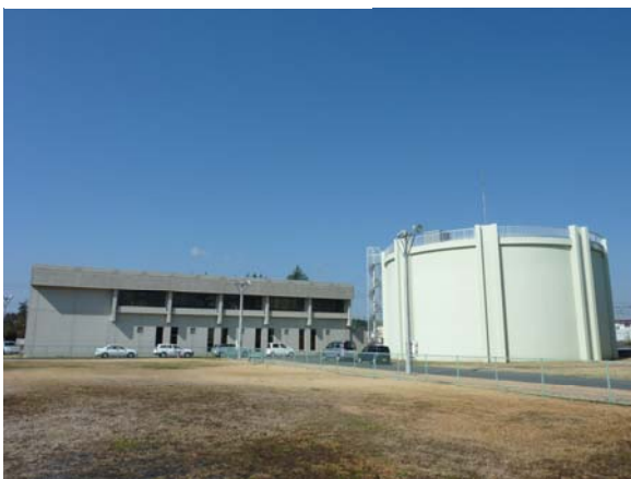
▲ 湖北水道企業団（玉里新配水場）
